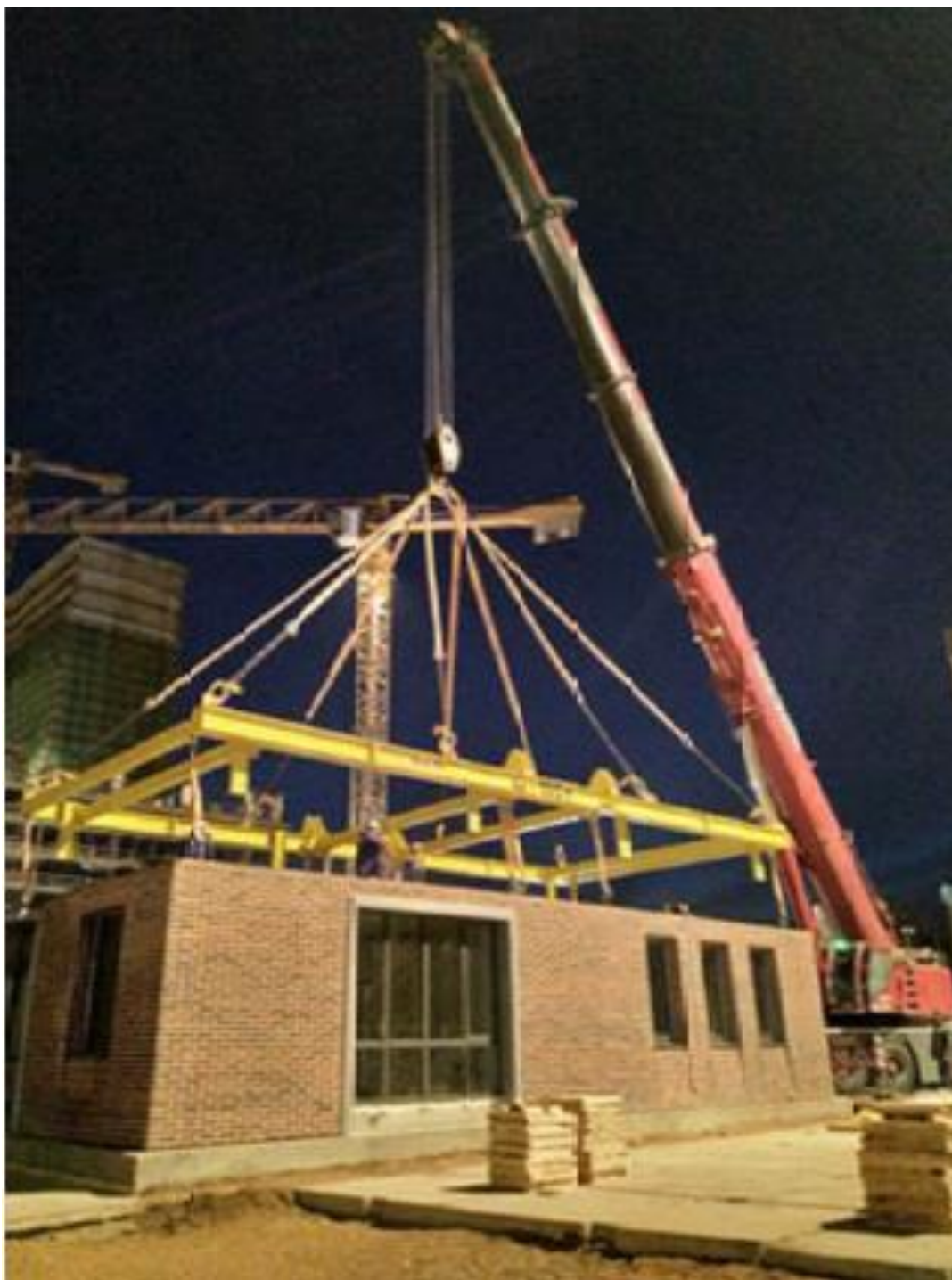
Рисунок 11.2 – Погрузка-выгрузка автомобильным или гусеничным краном
